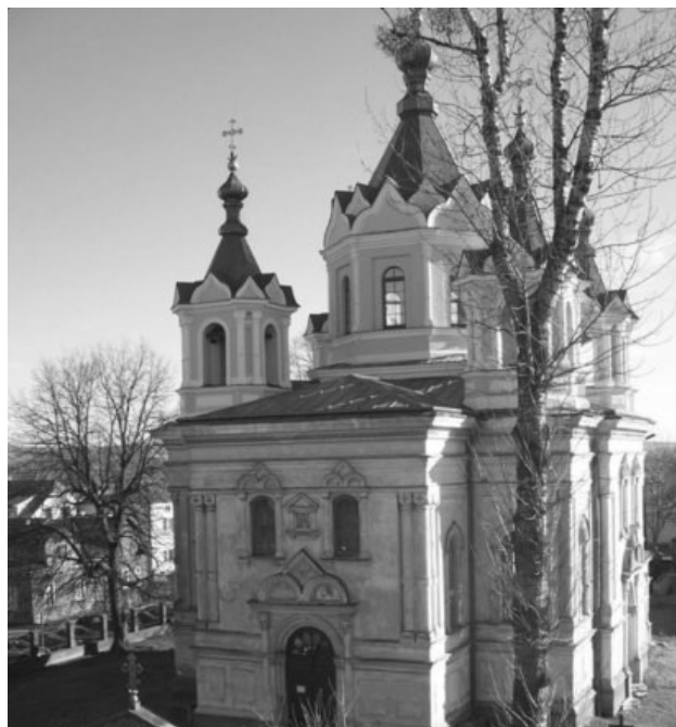
Prace remontowo-konserwatorskie, Cerkiew w Tomaszowie Lubelskim
