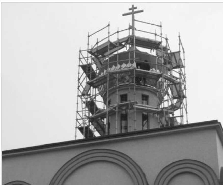
Remont cerkwi w Siedlcach, fot.: ks. Sławomir Kochan
